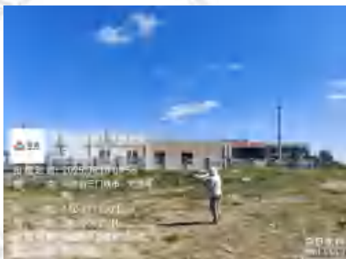
升压站外围墙南 20m 处
