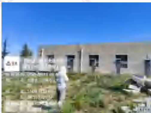
升压站外围墙南 5m 处
