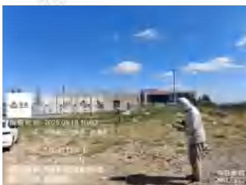
升压站外围墙南 30m 处
