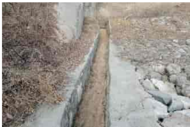
尾矿库坝肩排水沟
