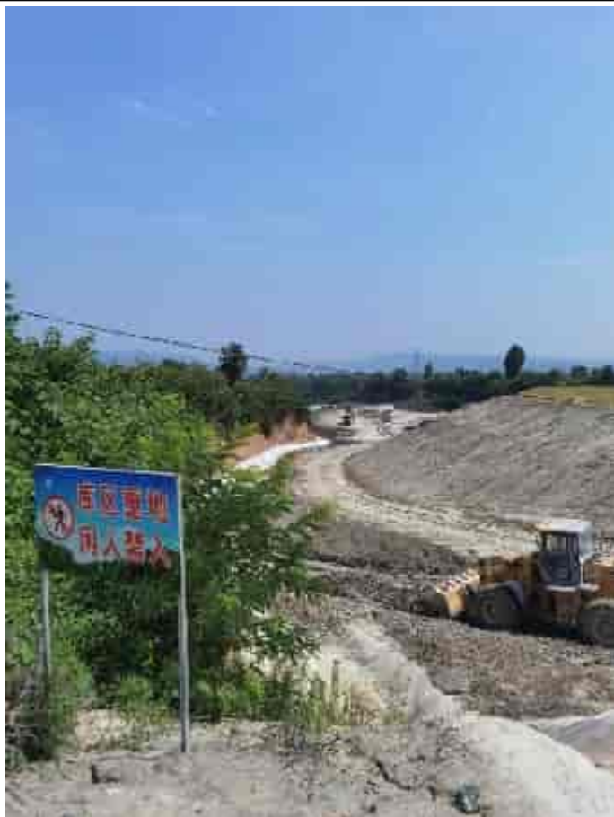
尾矿库地下水防渗土工膜
