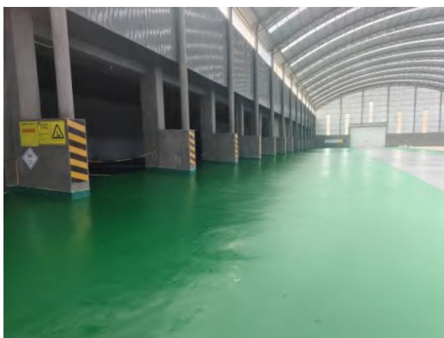
2#危废仓库（在建工程）
