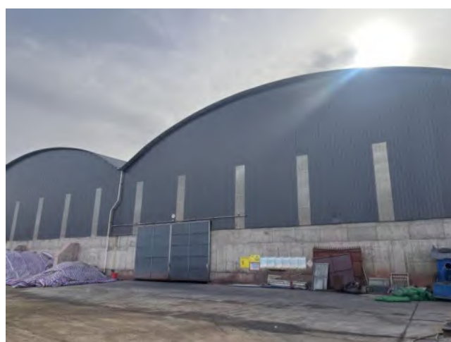
项目南侧秦岭冶炼现有厂房
