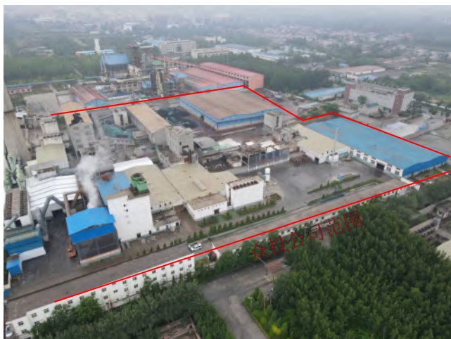
众投公司厂区航拍图
