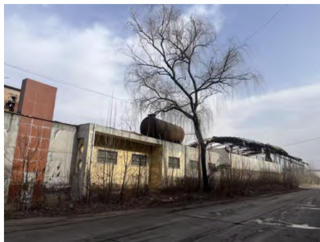
项目北侧闲置工业厂房
