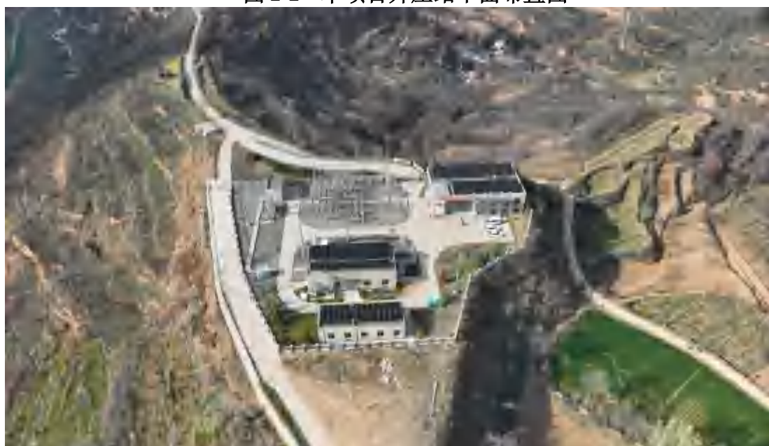
图 2-3 升压站现状情况航拍图
