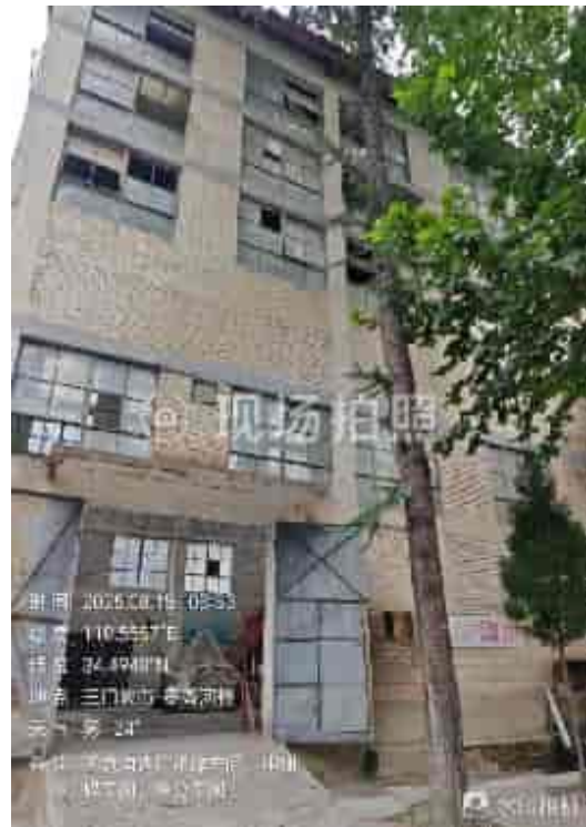
四范沟选厂粗碎车间、中细碎车间、筛分车间
