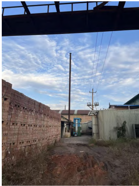
输送除尘器及排气筒 (DA003)
