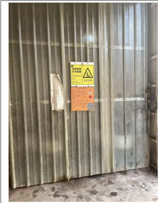
现有危废暂存间
