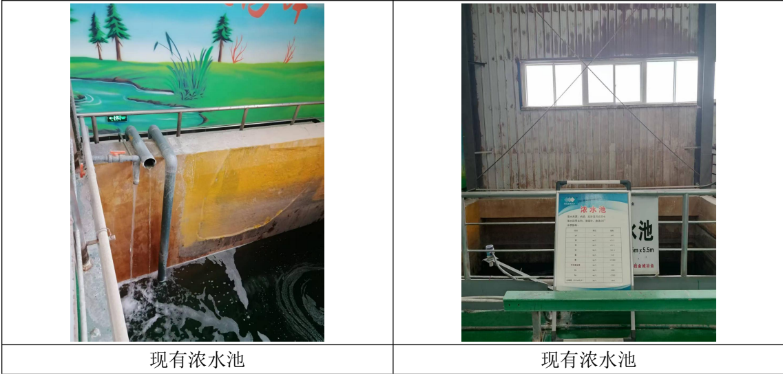
附图 11 项目现场照片
