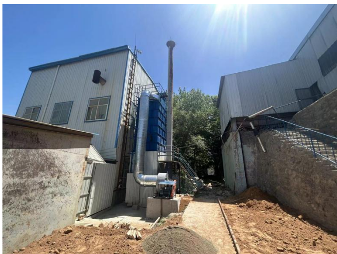
选厂破碎筛袋式除尘器
