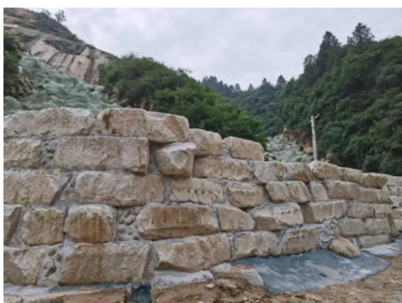
遗留废石堆场挡土墙
