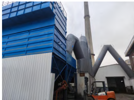
熔炼烟气冷却烟道+袋式除尘器
