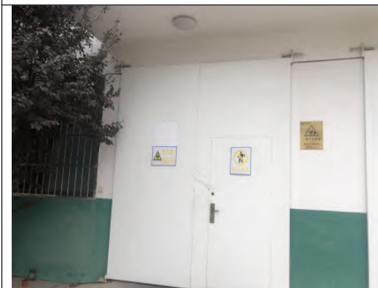
一般固废暂存间
