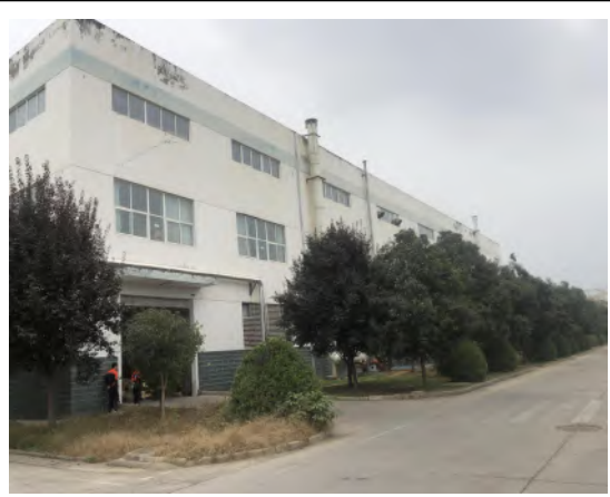
现有工程排气筒
