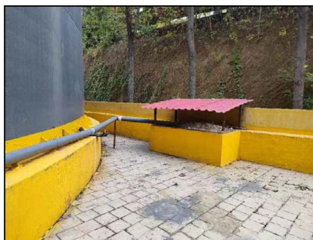
厂区现有硫酸储罐围堰及酸雾吸收池
