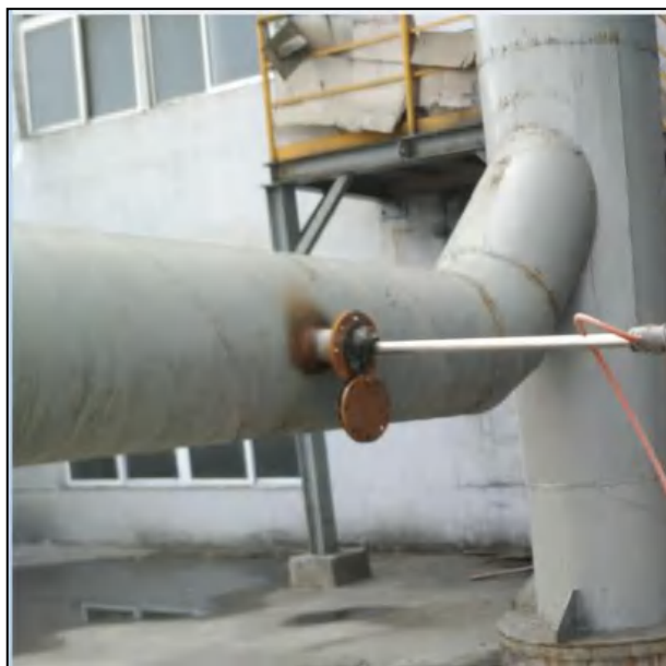
图 11-3-3 一般排放口采样口设置情况
