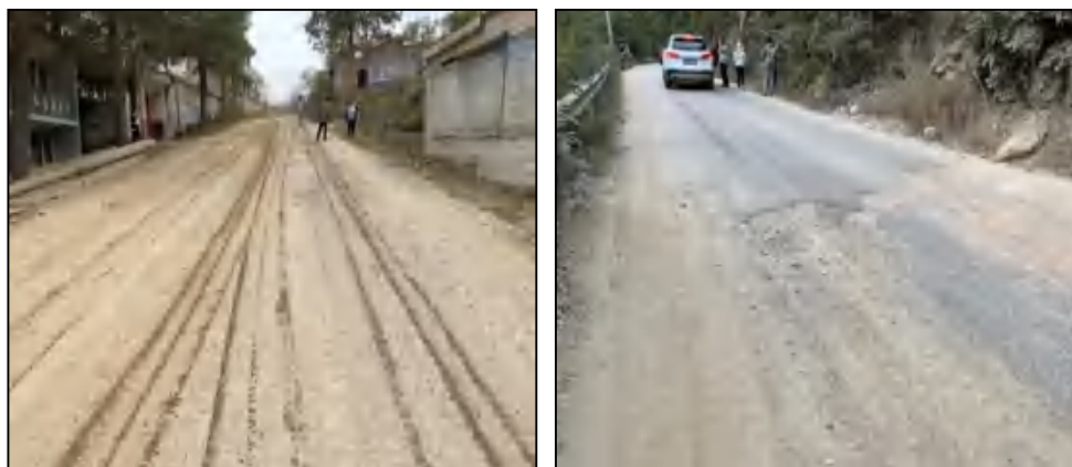
图 3 部分路面损坏路段现状
