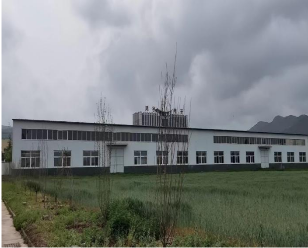
项目厂区现状
